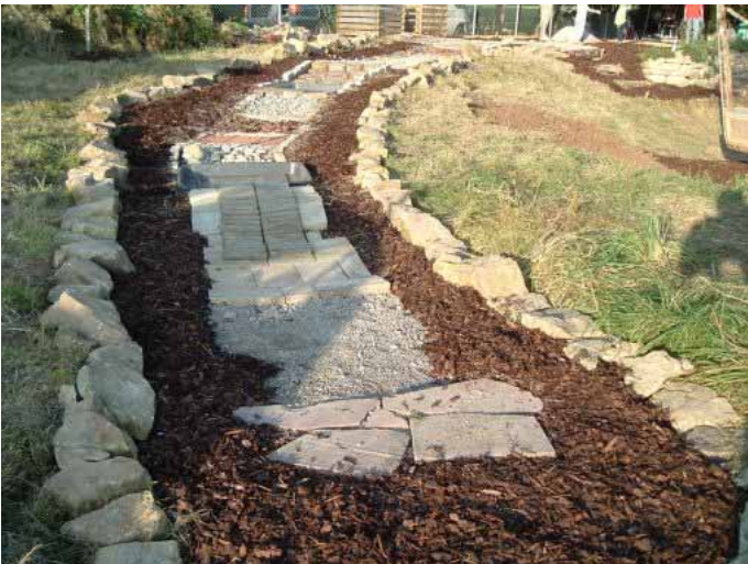
Zuletzt wird der neue angelegte Barfußpfad an den Seiten mit Rindenmulch umfasst...
