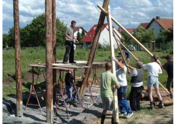
Aufrichten der tragenden Stämme - 06/2007
