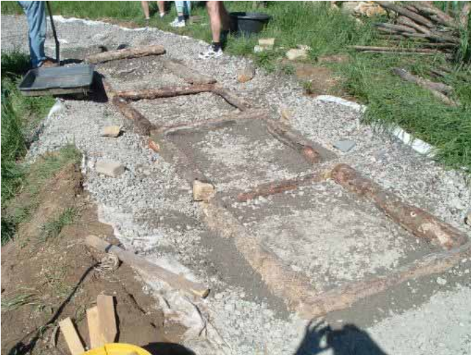
Auf dem Unterbau werden die Umfassungen für die „Bodenbeläge“ neu aufgesetzt...
