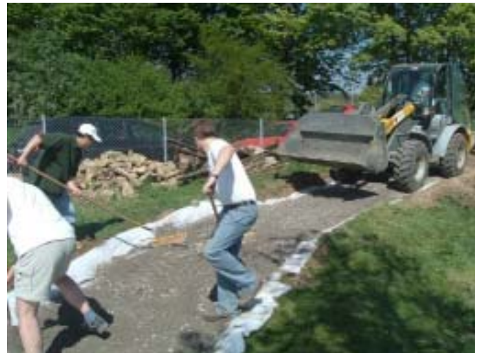
... und gleichmäßig glatt gezogen. Darauf wird der Barfußpfad später wieder aufgebaut.
