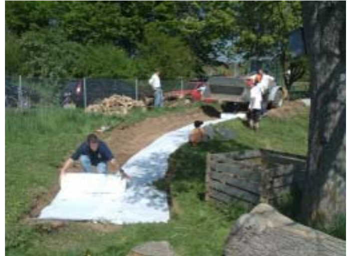
In die entstandene Auskoffnung wird Geotextil eingebracht...
