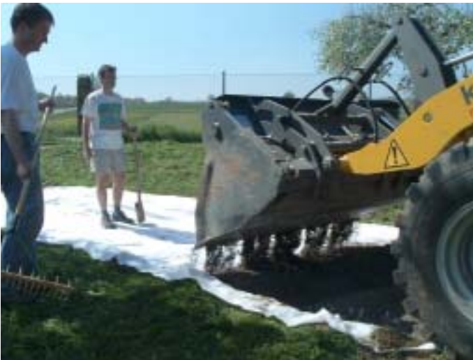
... darauf wiederum wird eine Schicht Schotter mit dem Radlader verteilt...
