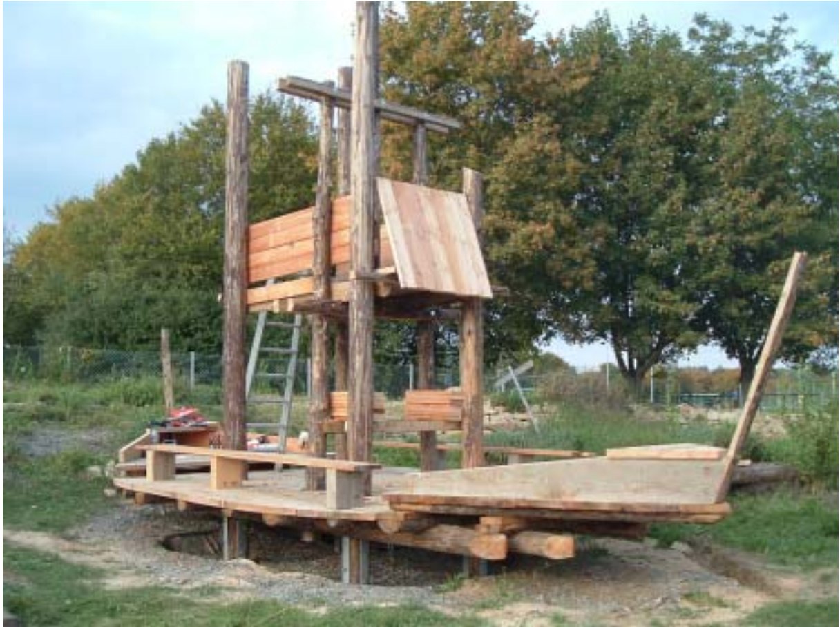
„Wetterschiff“ kurz vor Fertigstellung 09/2007
